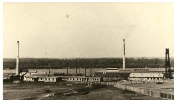
Integralni metalurški ciklus činili su : Topionica gvožđa u Majdanpeku sa rudnicima u tom području, kao i postrojenja u Smederevu: Čeličana sa Siemens Martinovom peći, Valjaonica profila, Valjaonica lima, Pocinkovaonica i prateći energetski objekti - Električna centrala, Gas-generatori, Kotlarnica, kao i ranije izgrađena finalna postrojenja - Fabrika čeličnih konstrukcija, Brodogradilište i Kovačnica.
